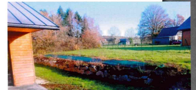
Pavillon locatif Laveix Aménagement d'une terrasse et enrochement du talus
